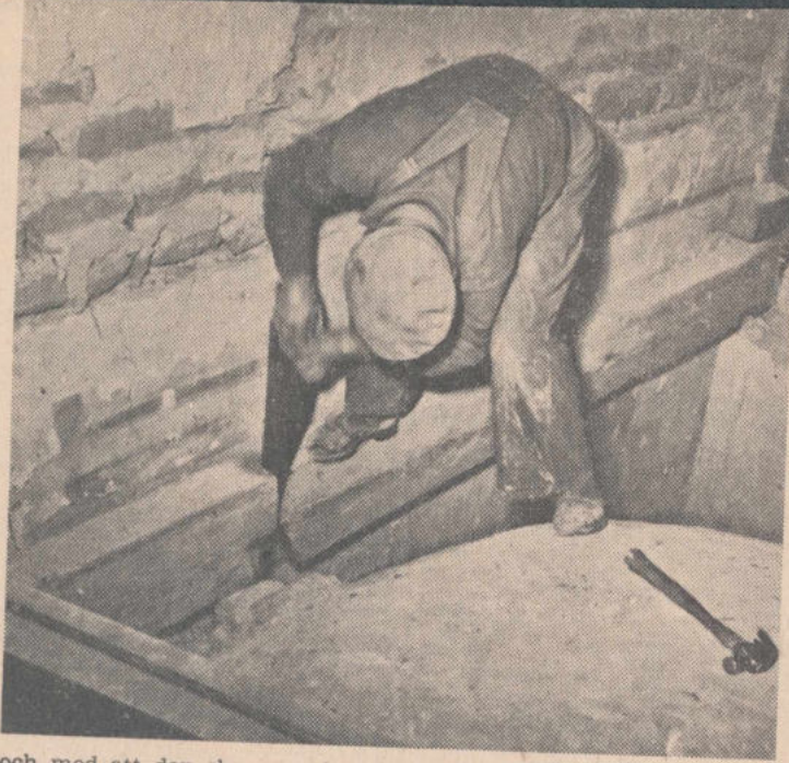
och med att den skymmande tvärbjälken kapades och togs bort blev den märklige bildsviten tillgänglig för studium
