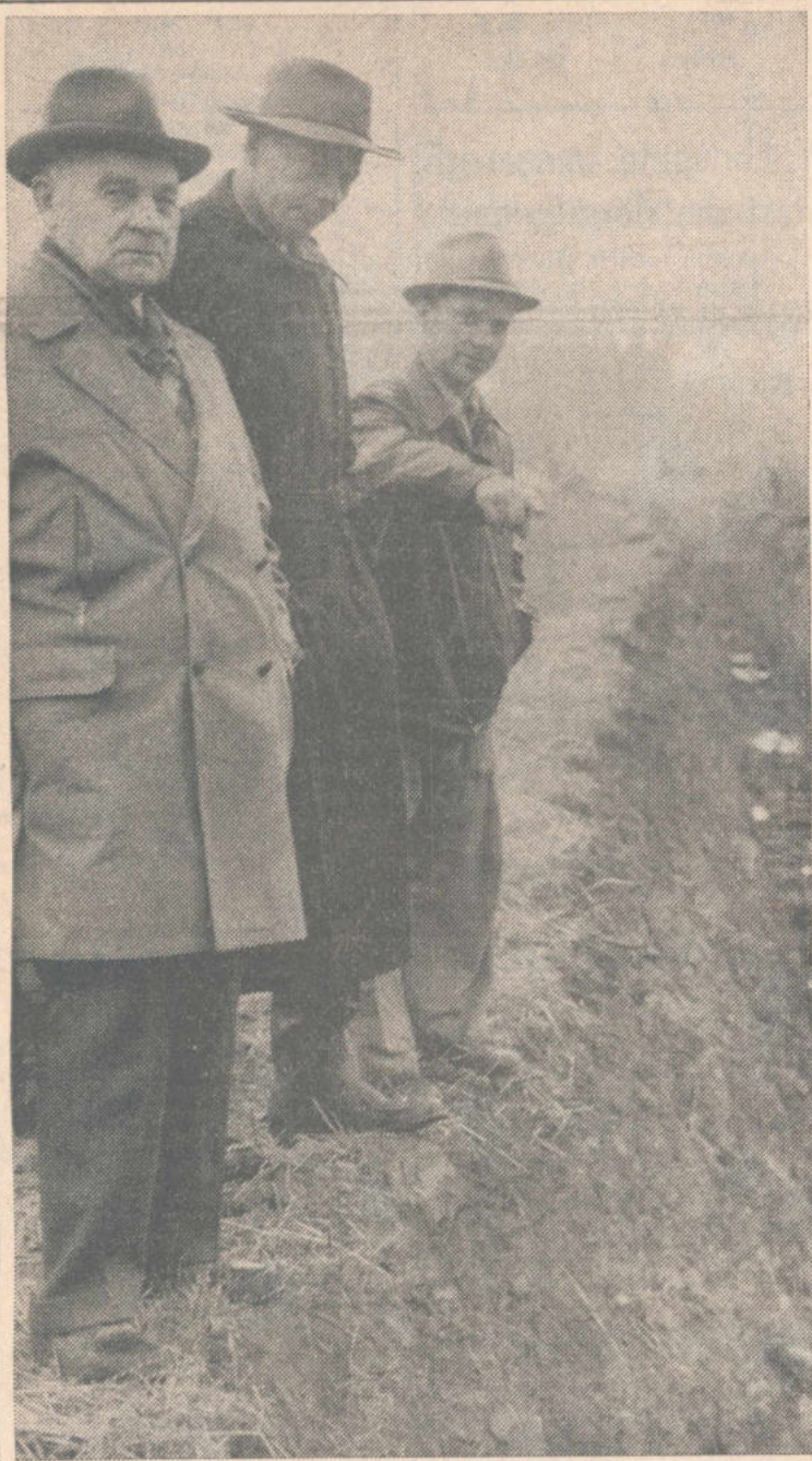
AVLOPP I BOBERG Närmare 1700 meter avloppsledning har läggts ned vid Korskrögsområdet i Boberg. Arbetet påbörjades för tre veckor sedan och vid det här laget är man ungefär halvvägs. På onsdagen synade byggnadskommittén arbetet och MT passade på att ta bilden ovan. Den visar fr. v. Joel Pettersson, Hugo Hall och Hans Viktorsson vid avloppsdiket. Se sidan 5.
