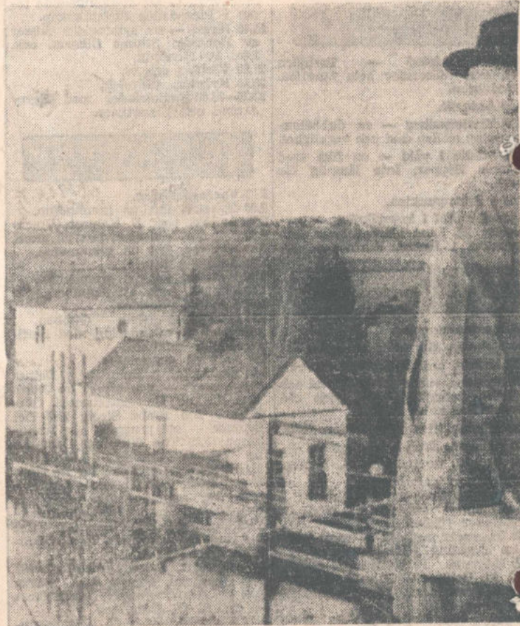
Kraftverket Vågforsen vid Svartån med driftsingenjör H. Thorén i förgrunden. Bilden tagen uppfra från östra åstranden.
