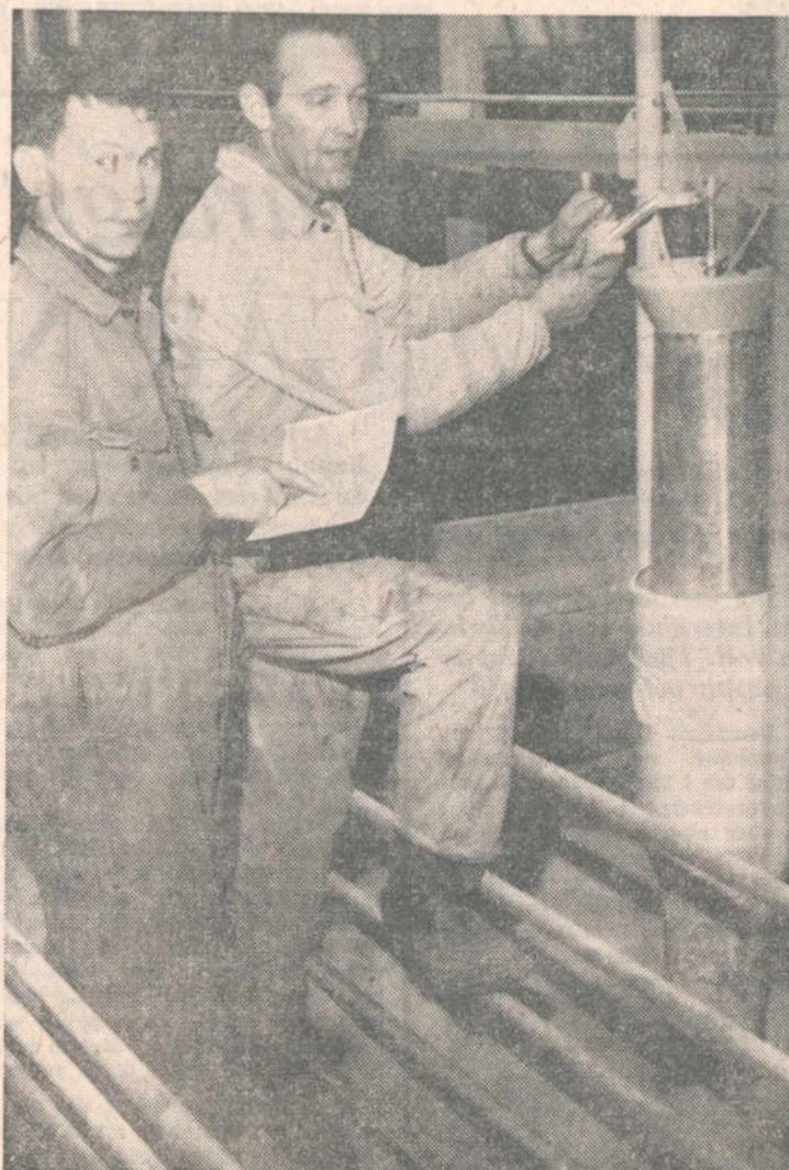
På Lotstad västergård i Skeppsås har lantbrukarna Harry och Willy Larsson installerat en automatisk golvutfodringsanläggning för svin som ur svensk synpunkt är av helt ny konstruktion. De båda bröderna Harry och Willy ses här ställa in vågbehållaren till nersläppscylindern.
