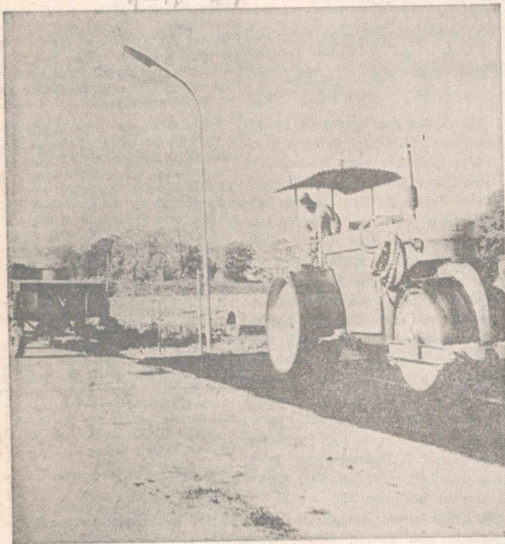
Asfaltering pågår vid planen intill brandstationen och bygdegården i Fornåsa
