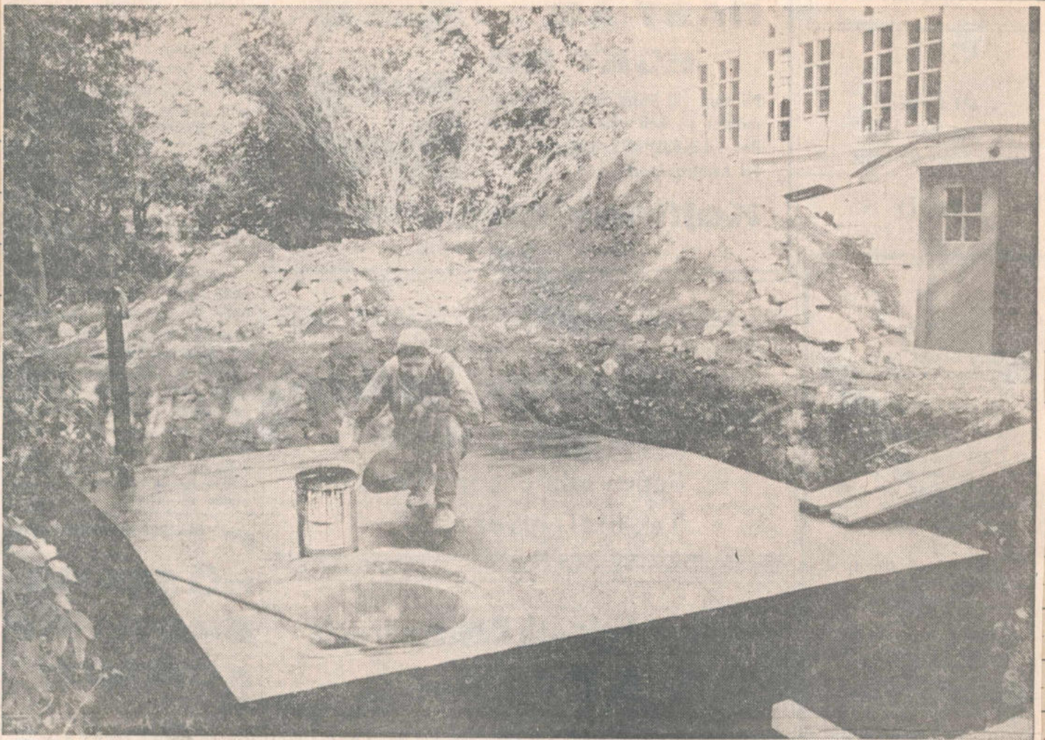
För att förbättra vattenkvaliteten i Skeppsås kyrkby har investeringar på 60.000 kr gjorts. Bl. a. har en råvattenbassäng lagts ned vid gamla skolan. Bassängen rymmer 18 kbm och vattnet ska därifrån gå igenom ett avjärnings- och ett avhärdningsfilter. Karl-Inge Andersson är på bilden sysselsatt med att täta betongbassängen.
